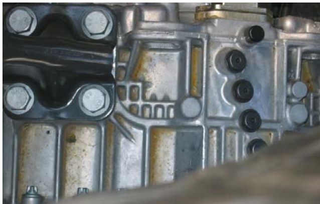
Hiontapölyä vaihteiston päällä
