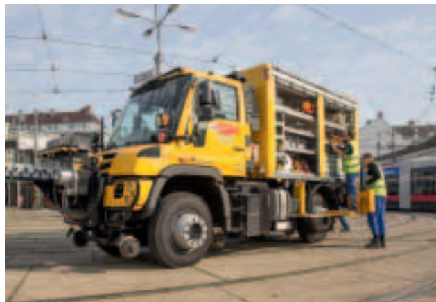
Kiskoilta suistuneen vaunun nosto takaisin kiskoille Unimogin avulla
